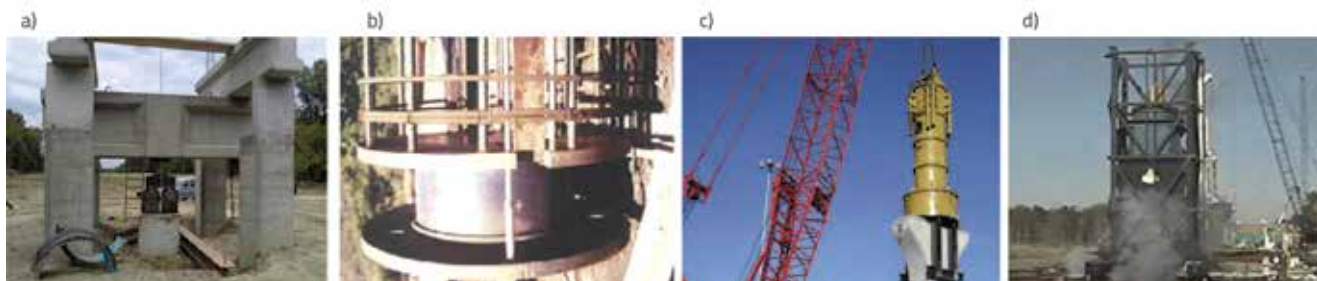
Slika 9. Terenska ispitivanja nosivosti pilota: a) statičkim postupkom; b) Osterbergovim ćelijama; c) dinamičkim postupkom; d) Statnamic postupkom [9]
