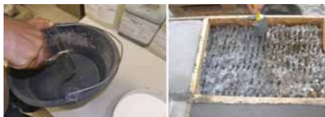
Slika 6. Priprema veznog sloja: doziranje i ručno miješanje morta s lateksom oznake LMC+ s utrljavanjem u površinu podloznog betona
