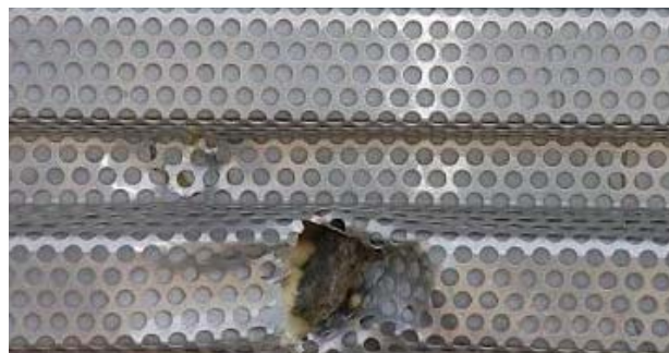
Slika 5. Oštećenje bukobranskog zida od izdizanja sitnijih zrna zastora
