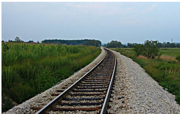
Slika 1. Klasična kolosiječna konstrukcija (sa zastornom prizmom)
