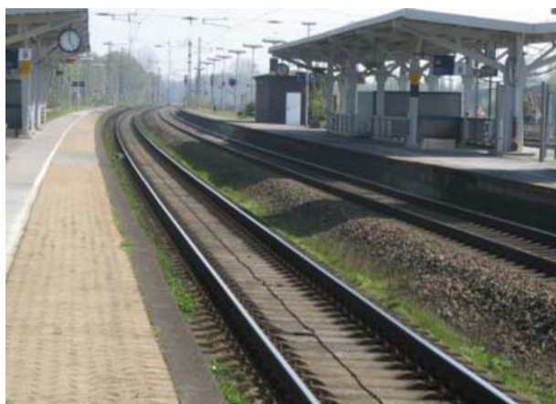
Slika 8. Rheda-Wiedenbrück željeznička stanica s kolosiječnom konstrukcijom „Rheda“ [8]
