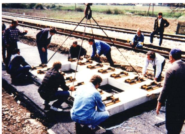
Slika 25. Kolosijek na čvrstoj podlozi na pruzi Zagreb – Sisak (ispitna dionica)
