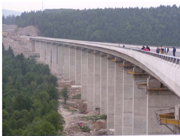
Slika 10. Most Zečeve drage u izgradnji
