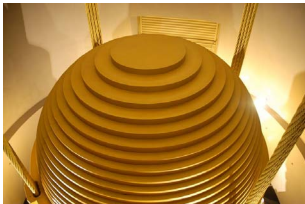
Slika 9. Uređaj s usklađenom masom (neboder Taipei)
