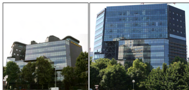
Slika 1. Izgled građevine: a) prije nadogradnje, b) danas
