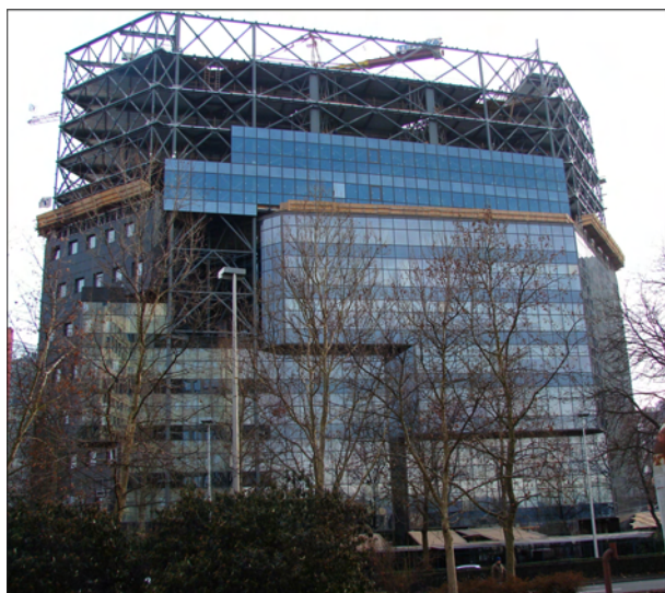
Slika 18. Dio nadogradnje sa stupovima kroz ab dio
