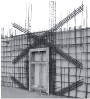
Slika 14. Armatura vezne grede povezanih zidova [9]
