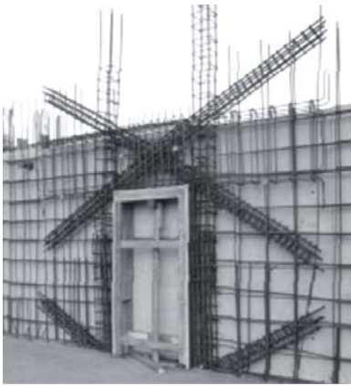
Slika 14. Armatura vezne grede povezanih zidova [9]
