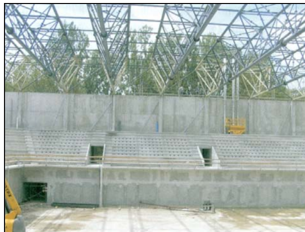
Slika 15. Krovni nosači u izvedbi
