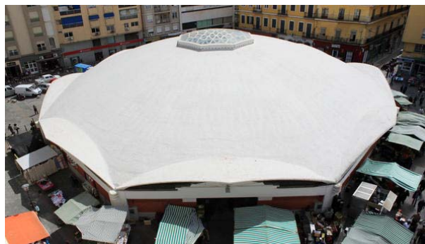
Slika 3. Hala tržnice u Algecirasu, Španjolska, sferna ljsuska (Torroja, 1933.)
