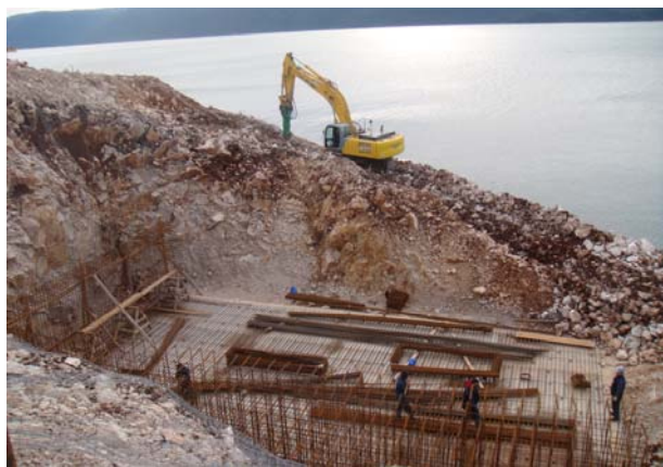
Slika 14. Gradnja mosta Pelješac - temelj stupa S2
