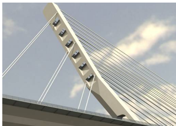
Slika 4. Pogled na pylon mosta Jarun
