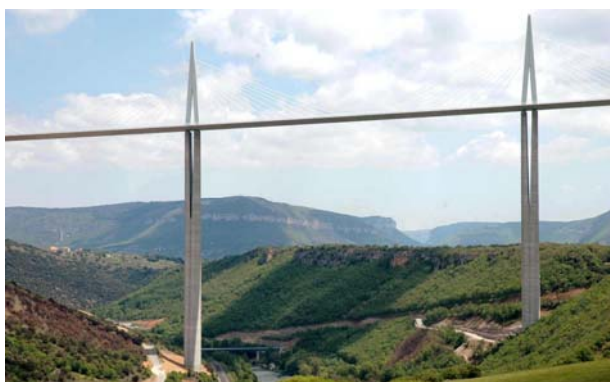
Slika 24. Viadukt Millau, dolina Tarn
