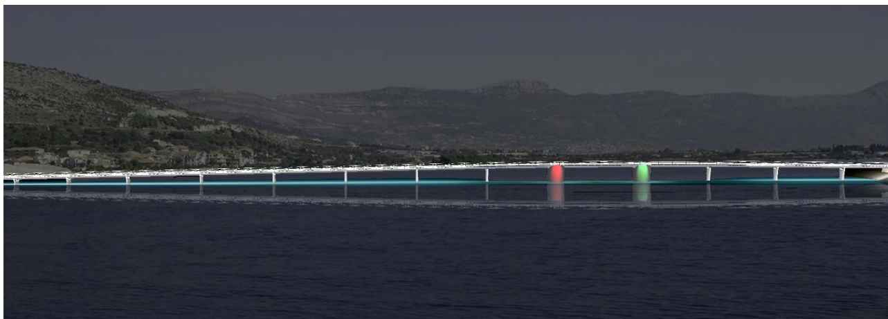
Slika 14. Dekorativna rasvjeta mosta
