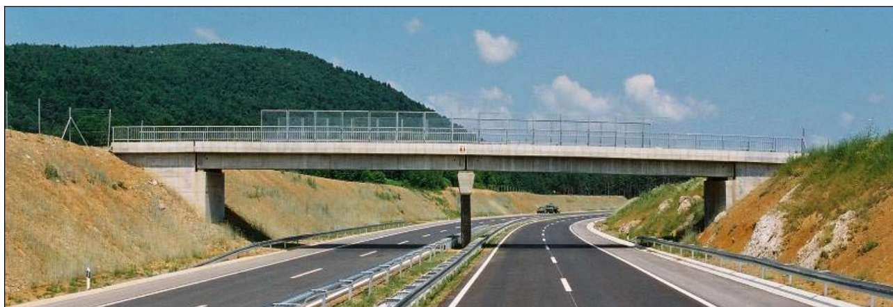
Slika 1. Uobičajeni nadvožnjak na hrvatskim autocestama u usjeku
