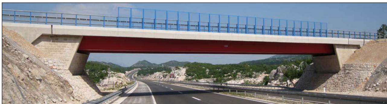
Slika 14. Spregnuti nadvožnjak Mucići presjek odabrane inačice
