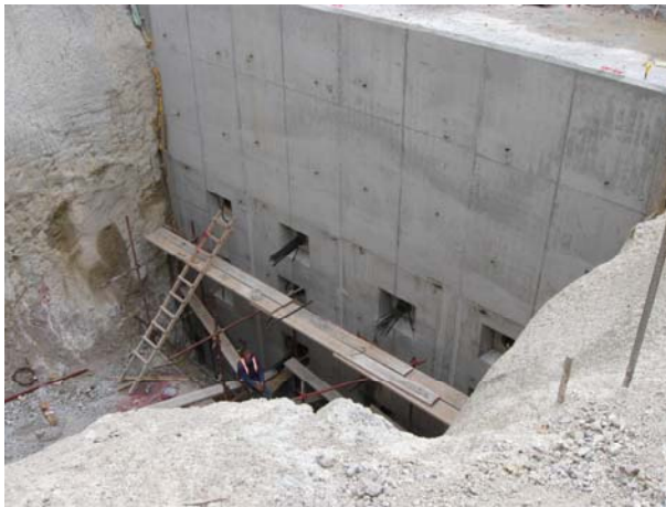
Slika 12. Sidreni zid na istočnoj obali
