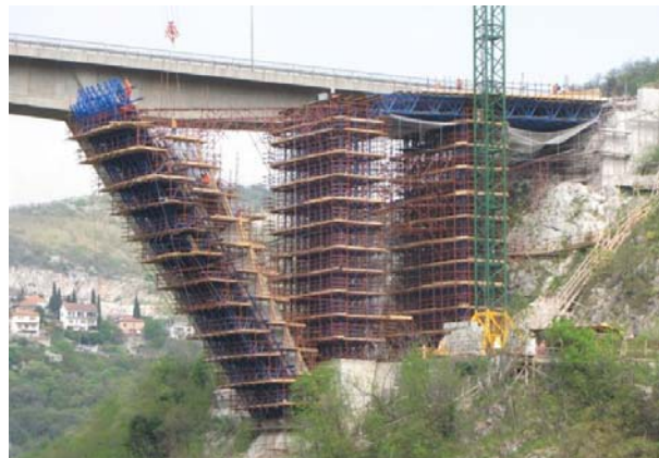
Slika 10. Montaža skele istočnog bočnog raspona i kosnika
