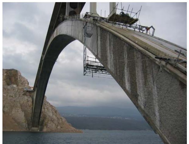
Slika 2. Sanacija maloga luka Krčkoga mosta
