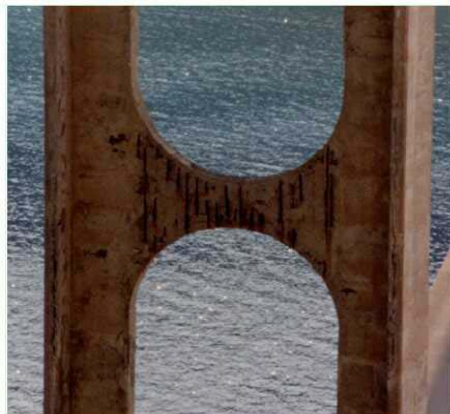
Slika 2. Stup S21: a) pukotine na stupu 1993.; b) odlamanja rubova pojasnice i širenje pukotina 2001.
