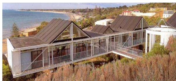
Slika 21. Izgled dogotovljene kuće
