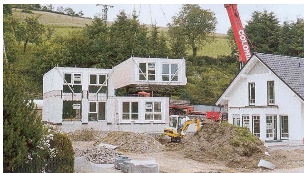
Slika 10. Montaža modula
