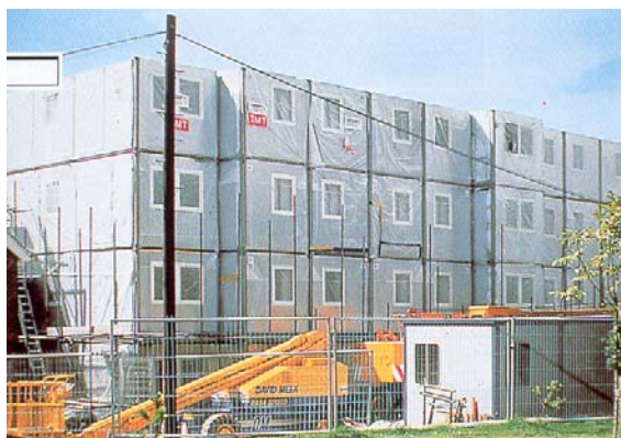
Slika 23. Montaža modula
