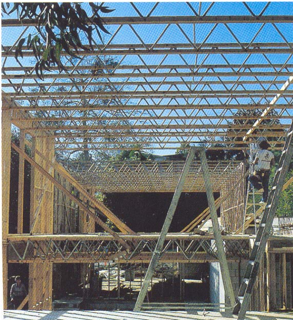
Slika 4. Sustav građenja TEST
