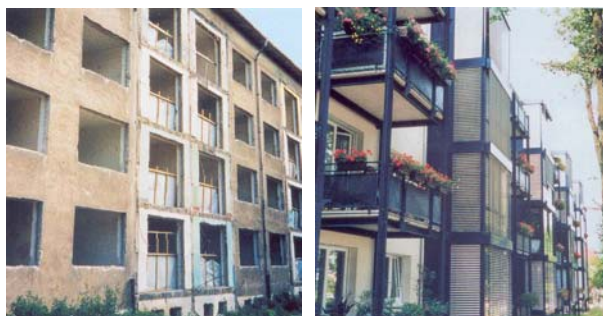
Slika 12. Primjer adaptacije i proširenja stare zgrade primjenom čeličnih okvira; a) prije adaptacije; b) nakon adaptacije
