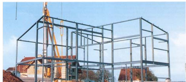
Slika 6. Okvirni sustav građenja čelikom
