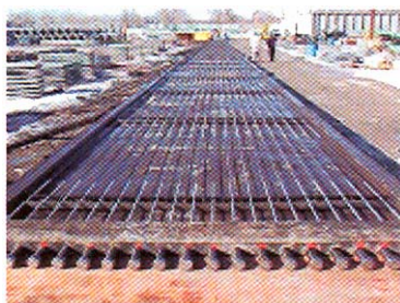
Slika 5. Primjena CFRP armature u prednapetim pločama [17]
