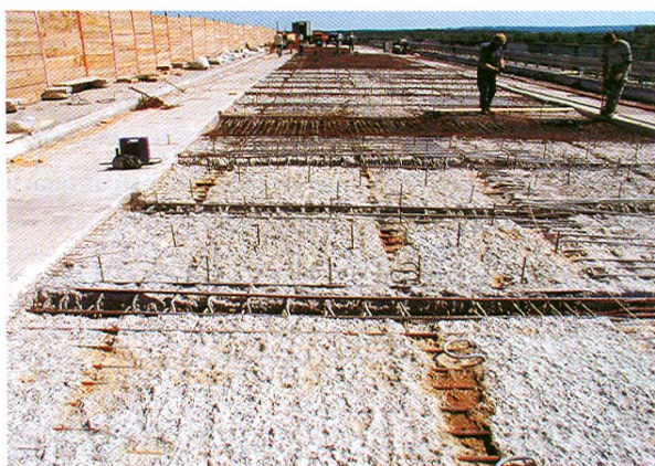
Slika 1. Skupi popravak kolničke konstrukcije mosta preko Save u Ivanjoj Reci
