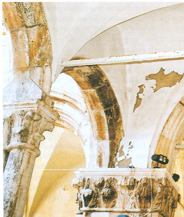
Slika 19. Položaj jedne od plitko sidrenih zatega na katu
