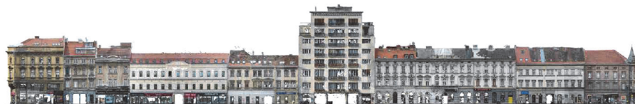
Slika 6. Ilica: prikaz pročelja zgrada u nizu Bloka 19 [2]
