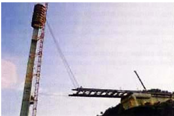
Slika 17. Navlačenje čeličnog sklopa uz pridržanje pomoćnim kabelima između pilona i upornjaka na dubrovačkoj strani
