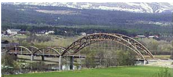
Slika 9. Bočni pogled na Tynset most, (rasponi 70+28+28 m)
