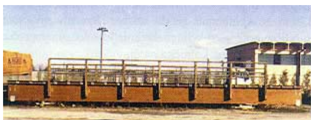
Slika 3. Most izveden na privremenoj lokaciji
