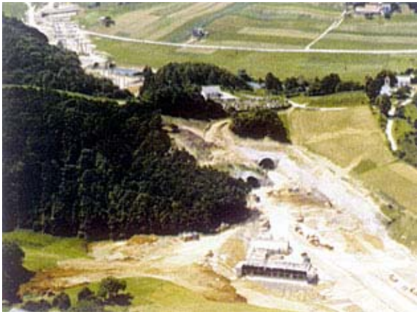
Slika 1. Gradilište tunela Sveti Marko
