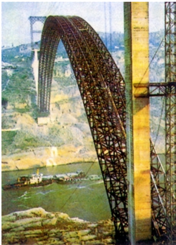
Slika 10. Izvedena lučna prostorna rešetkasta konstrukcija mosta Wanxian Yangtze
