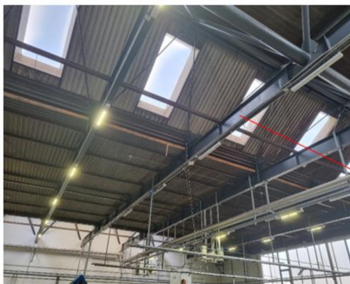
Slika 5.4 Fotografija sekundarnog nosača krovne konstrukcije
