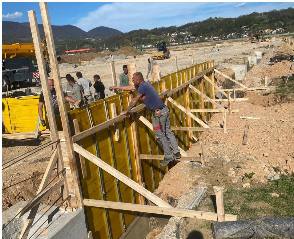
Slika 25 Montaža oplata obodne fasadne grede
