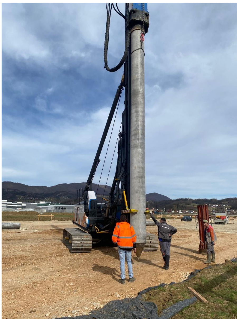
Slika 12 Junttan PM20 neposredno pred početak pobijanja
