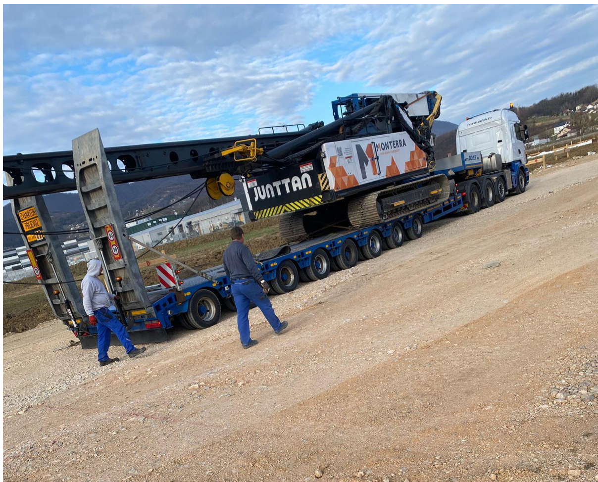
Slika 11 Stroj za pobijanje Junttan PM20
