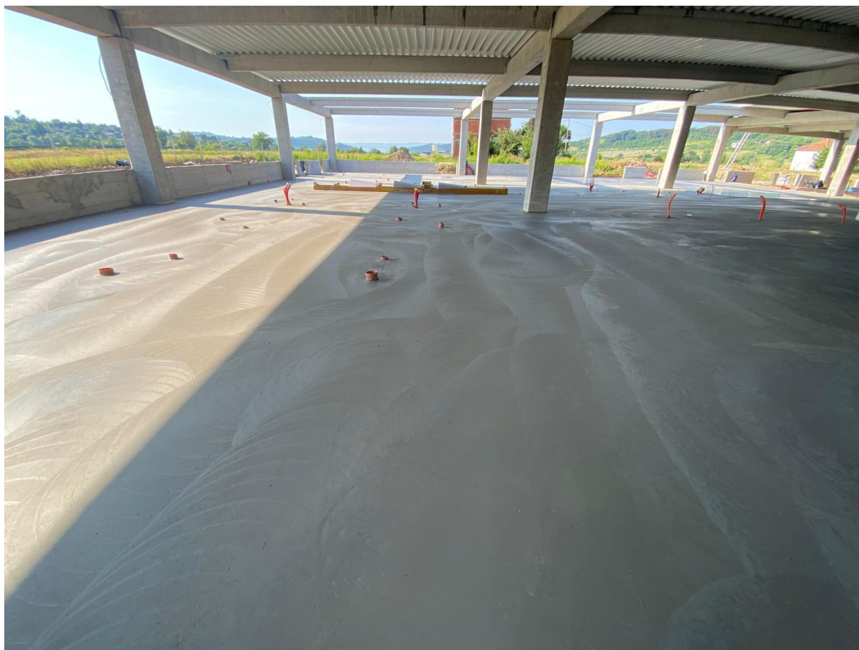
Slika 37 Podna ploča nakon završne obrade helikopterima.
