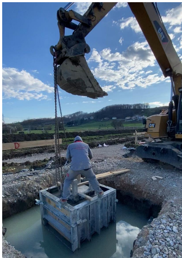
Slika 20 Izvlačenje unutarnje oplata temeljne čašice
