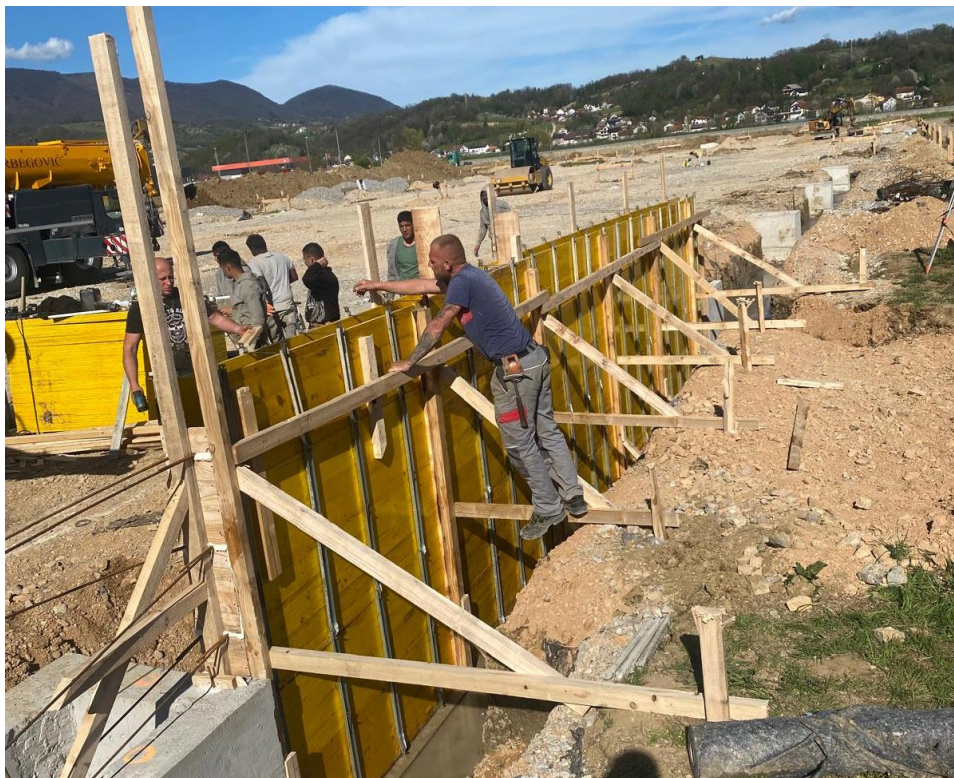
Slika 25 Montaža oplata obodne fasadne grede
