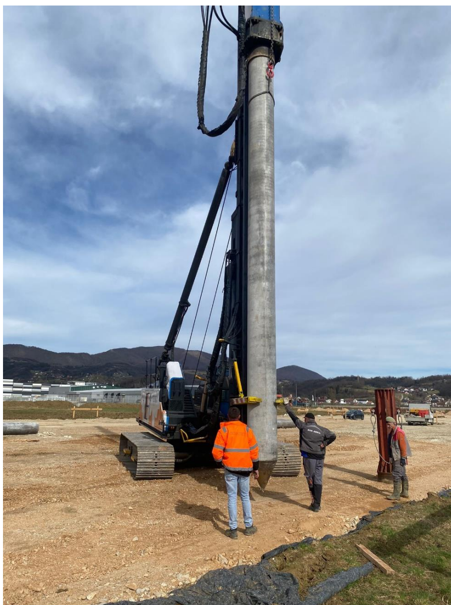
Slika 12 Junttan PM20 neposredno pred početak pobijanja
