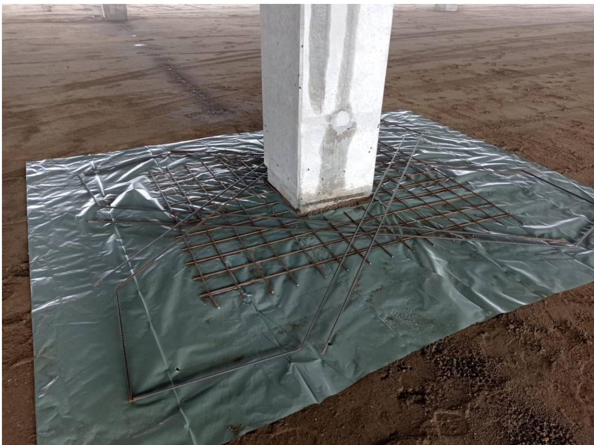
Slika 36 Armatura oko stupova
