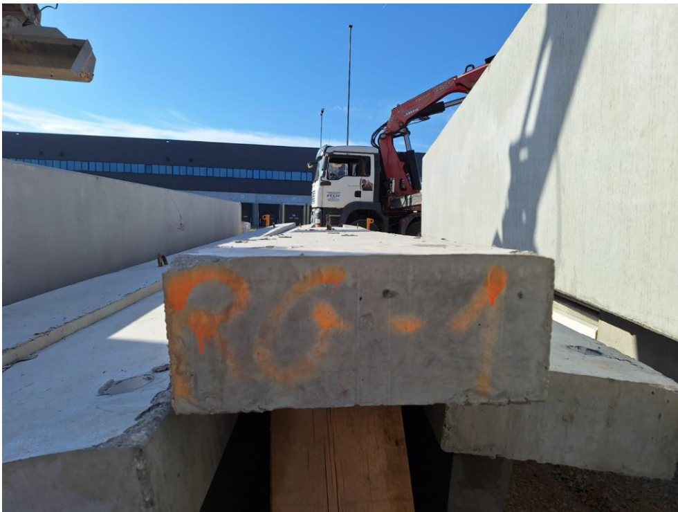
Slika 10: Deponirana rubna greda
