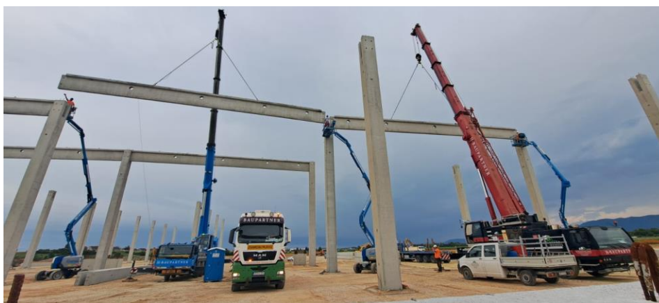
Slika 36: Montaža glavnih nosača
