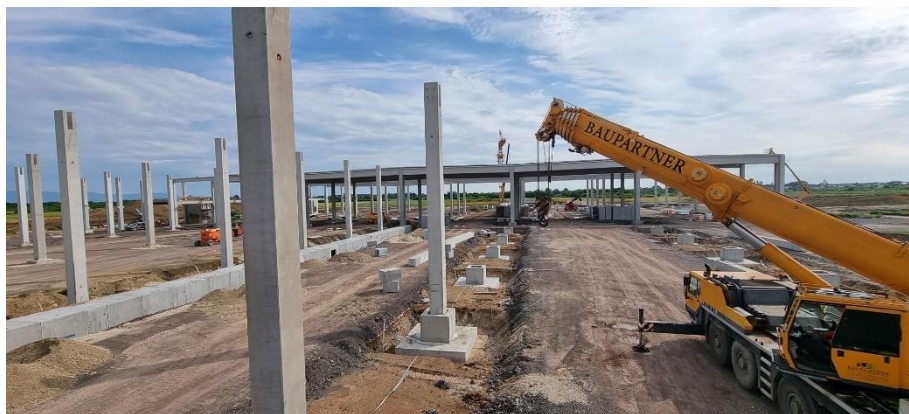
Slika 4: Vertikalna konstrukcija: stupovi
