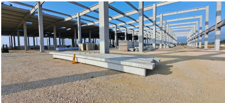
Slika 30: Deponiranje sekundarnih nosača na gradilištu
