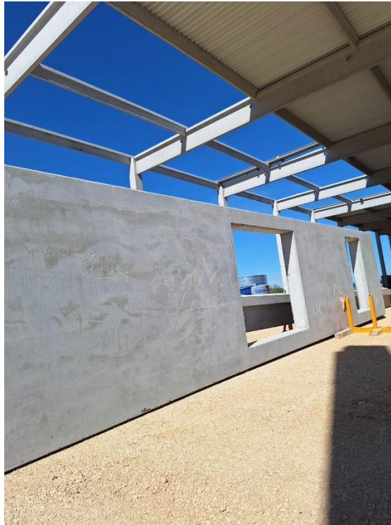
Slika 16: Armiranobetonski predgotovljeni element, izvor: autorska fotografija s gradilišta
