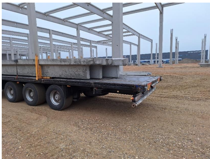
Slika 33: Dovoz sekundarnih nosača
