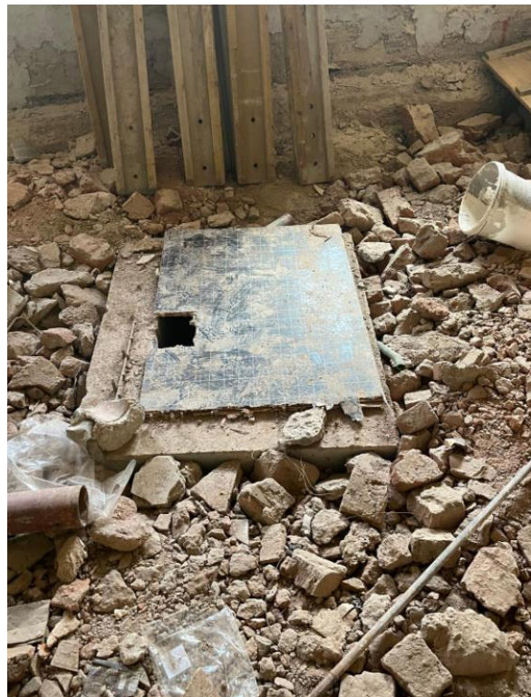
Slika 35.: Zaštita postavljena na otvor šahta
