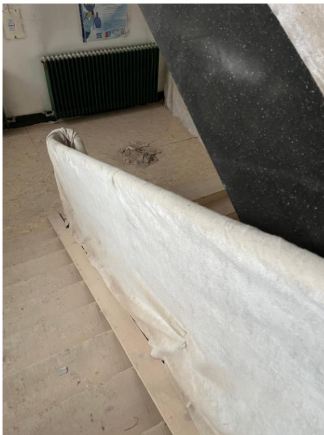
Slika 7.: Zaštićena ograda i rukohvat
