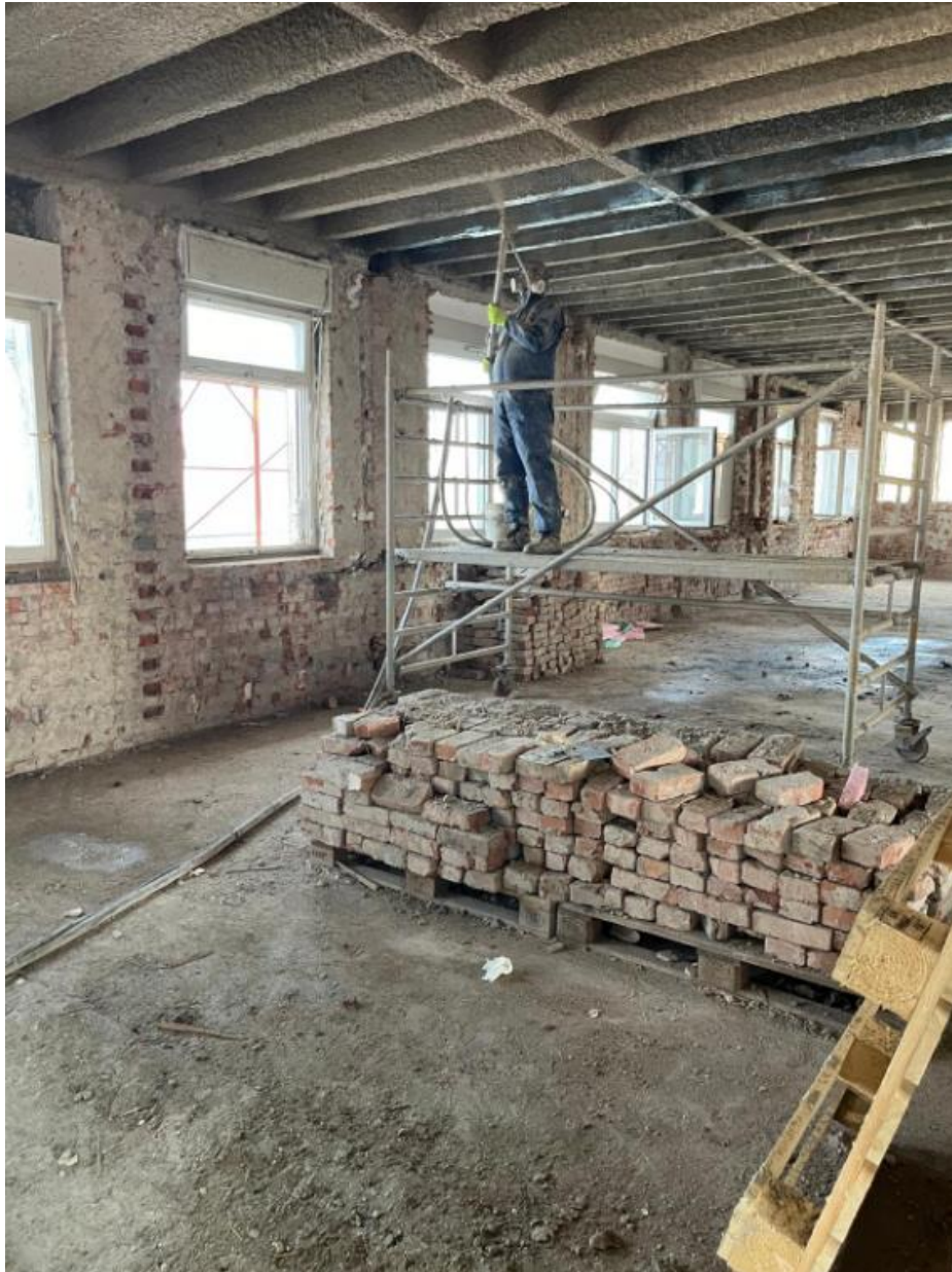
Slika 39.: Ispravno korištenje skela na kotačima
