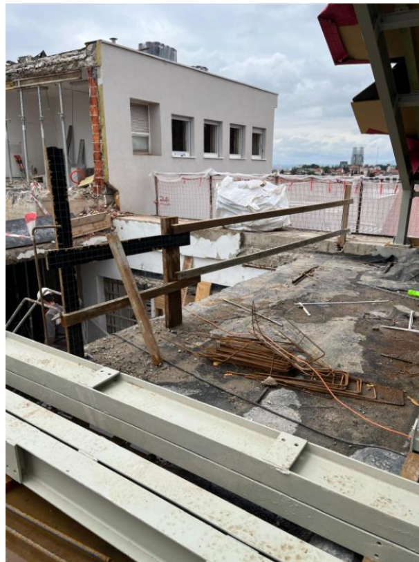
Slika 29.: Zaštita od pada
