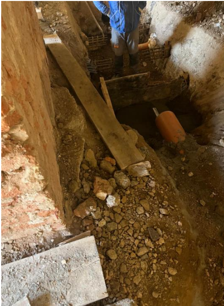
Slika 44.: Daska kao rampa za prijelaz
