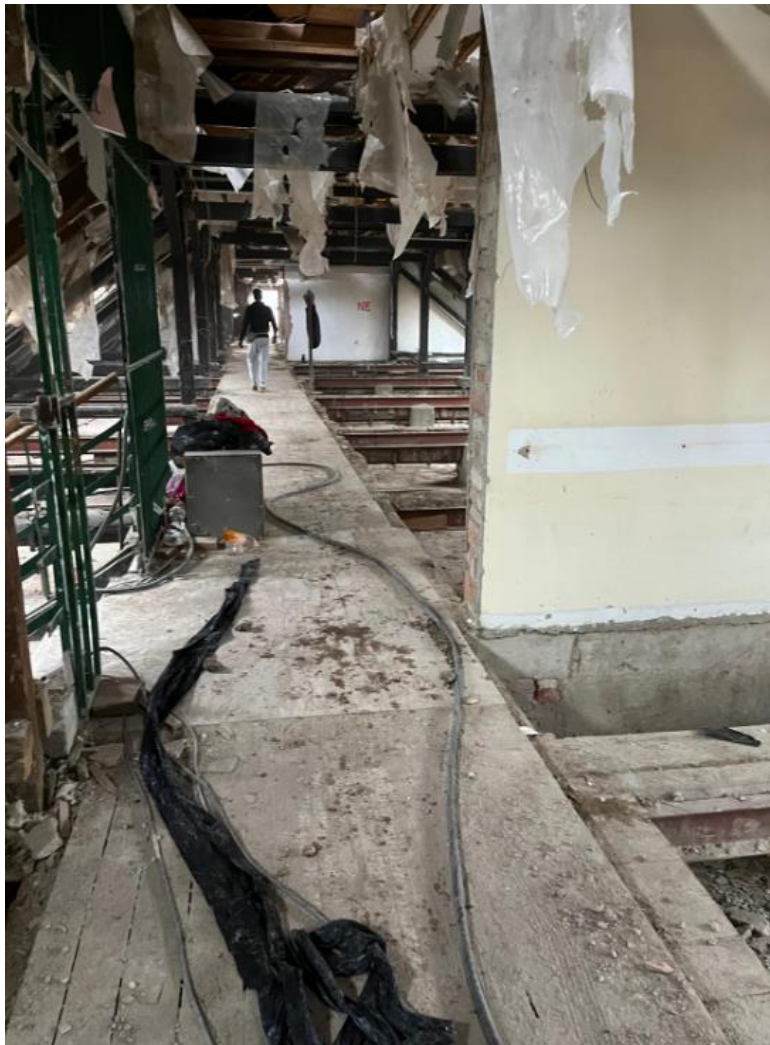
Slika 17.: Krovna konstrukcija tijekom uklanjanja
