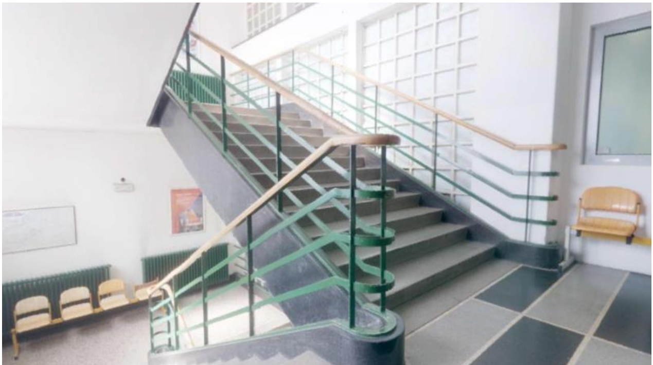
Slika 4.: Izgled elemenata obuhvaćenih konzervatorskom zaštitom prije obnove (Štampalija, 2023)
