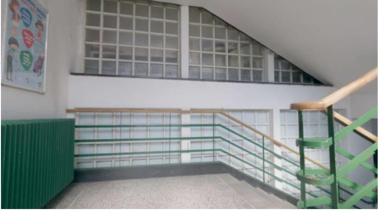
Slika 5.: Izgled elemenata obuhvaćenih konzervatorskom zaštitom prije obnove (Štampalija, 2023)
