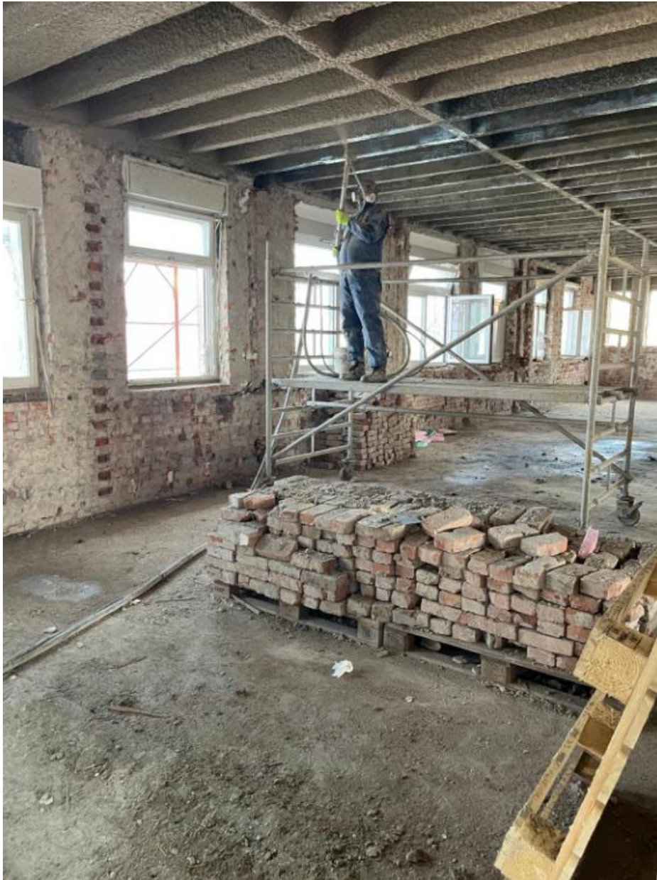
Slika 39.: Ispravno korištenje skela na kotačima
