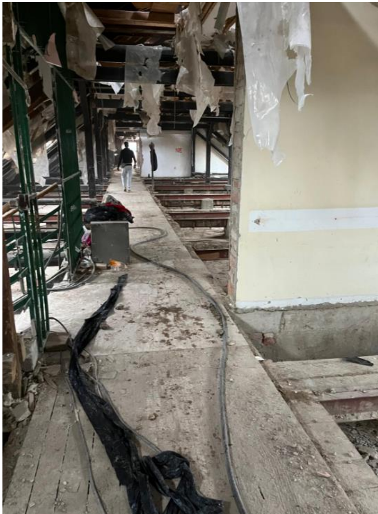
Slika 17.: Krovna konstrukcija tijekom uklanjanja
