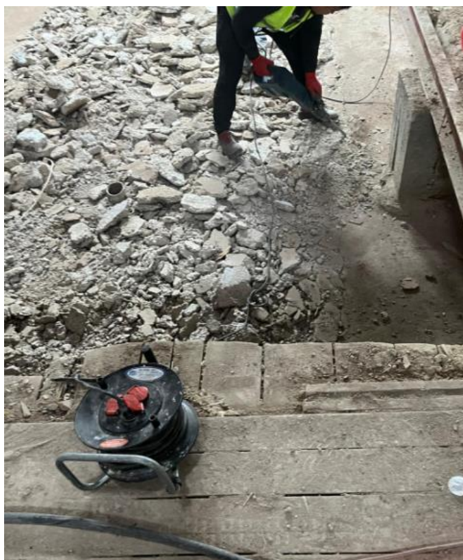
Slika 18.: Uklanjanje slojeva poda
