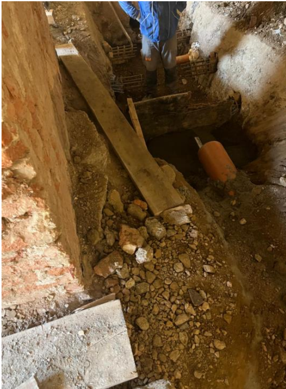
Slika 44.: Daska kao rampa za prijelaz
