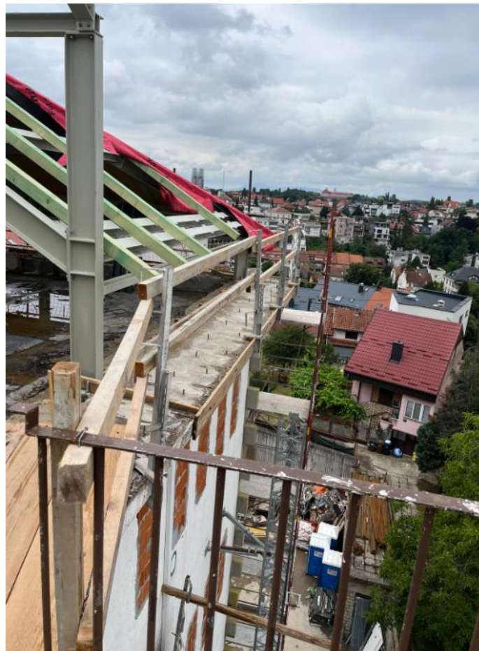
Slika 23.: Ograda na sjevernom dijelu krova
