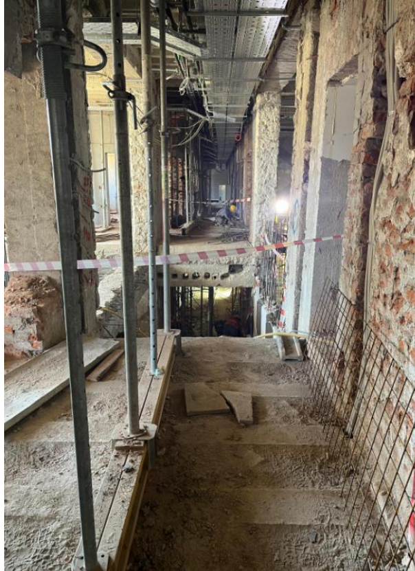
Slika 30.: Traka za označavanje opasne zone
