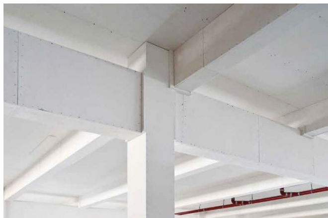
Slika 16. Zaštita čeličnih elemenata pločastim elementima
