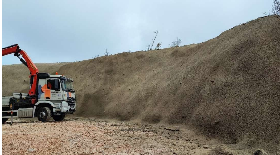
Slika 10. Zaštita pokosa mlaznim betonom
