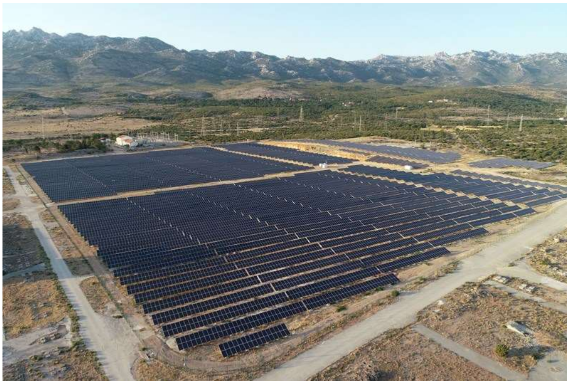
Slika 11.: Sunčana elektrana Obrovac (HEP, n.d. a)
