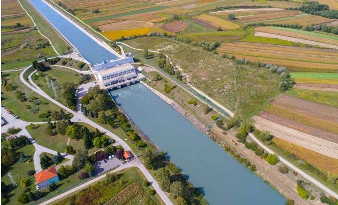
Slika 16.: Hidroelektrana Varaždin (HEP Proizvodnja, n.d. b)
