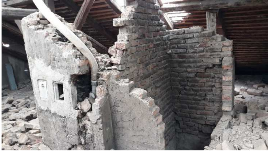
Slika 25: Južni svjetlarnik stradao u potresu 2020.
