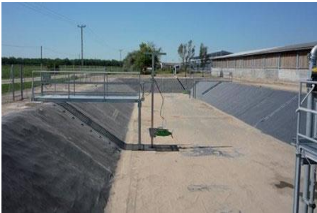
Slika 7. Korištenje otpadne vode kao tehnološke na stočarskoj farmi
