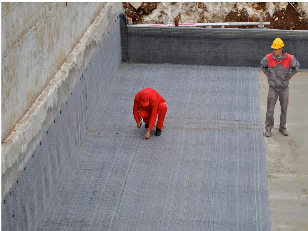
Slika 9. Korištenje otpadne vode za u proizvodnji hidroizolacijskih materijala i njihovom korištenju na gradilištima ( https://palir.hr/hidroizolacija-temelja/ )
