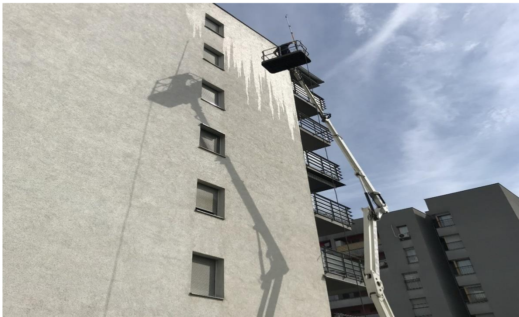
Slika 8. Korištenje otpadne vode za čišćenje fasada ( https://cisto.hr/pranje-i-pjeskarenje-fasade/ )
