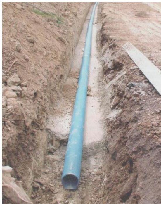
Slika 3 Plastična drenažna cijev na podlozi od betona [4]
