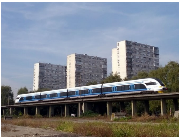
Željeznički nadvožnjak u istočnom dijelu grada Zagreba
