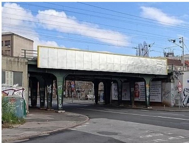
Željeznički nadvožnjak iznad Adžijine ulice
