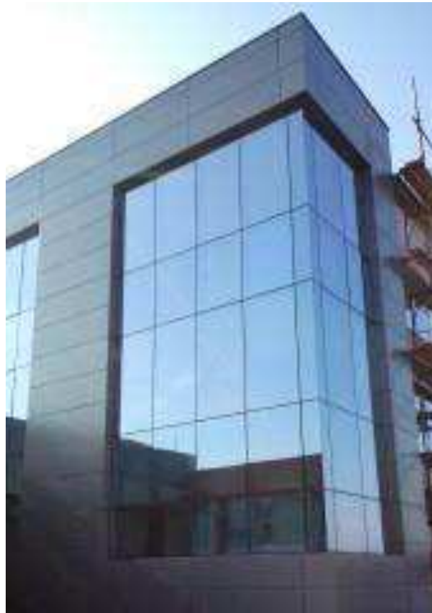
Slika 28: Primjer strukturalne obloge (Izvor: [51])
