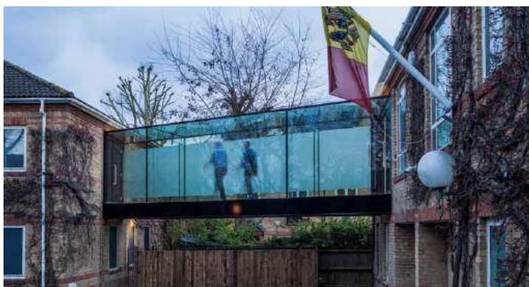
Slika 18: Primjer staklenog pješačkog mosta (Izvor: [31])
