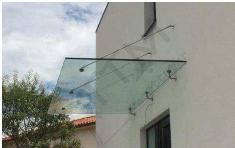
Slika 23: Točkasto oslonjena nadstrešnica (Izvor: [40])
