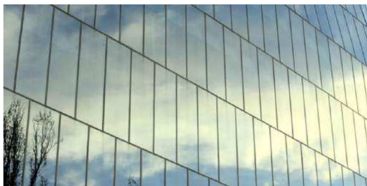
Slika 30: Primjer polustrukturalne obloge (Izvor: [54])
