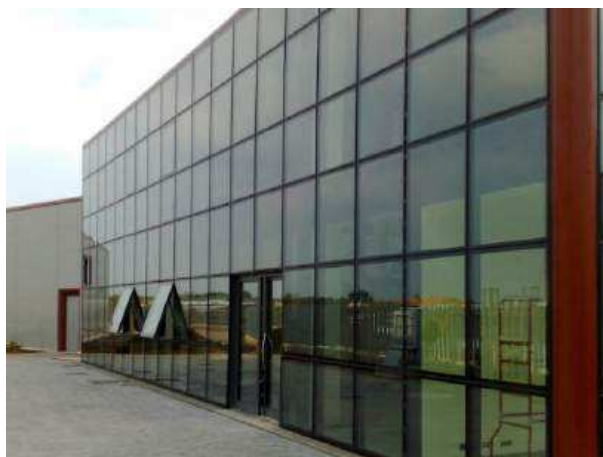
Slika 27: Primjer kontinuirane obloge (Izvor: [49])
