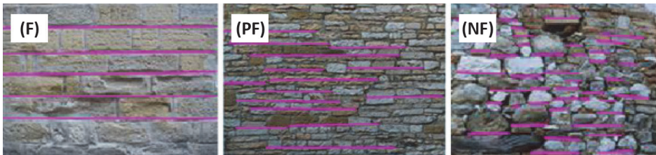
Slika 4. Raspored vertikalnih sljubnica [5]
