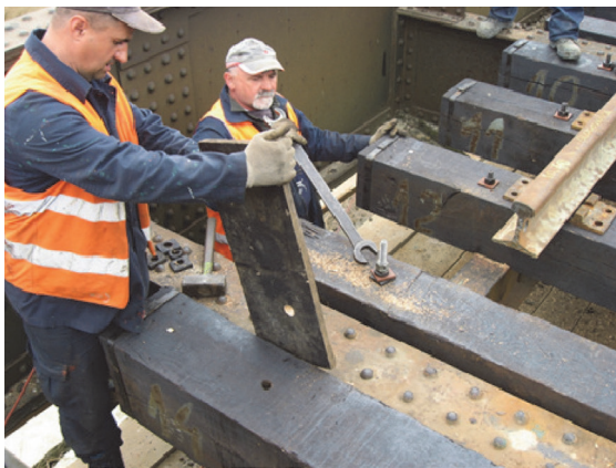
Slika 1. Pričvršćivanje drvenih pragova na čeličnu mosnu konstrukciju
