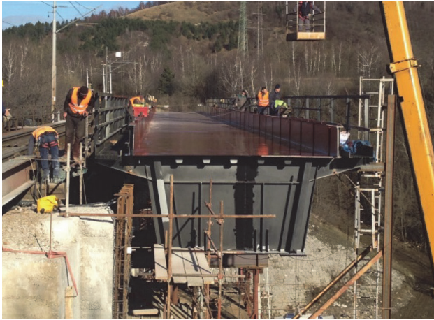
Slika 3. Čelična konstrukcija mosta, faza izvedbe
