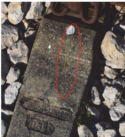
Slika 4. Pukotina TIP 1
