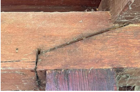
Slika 53.: Tesarski spoj na prijeklop (Izvor: [29])
