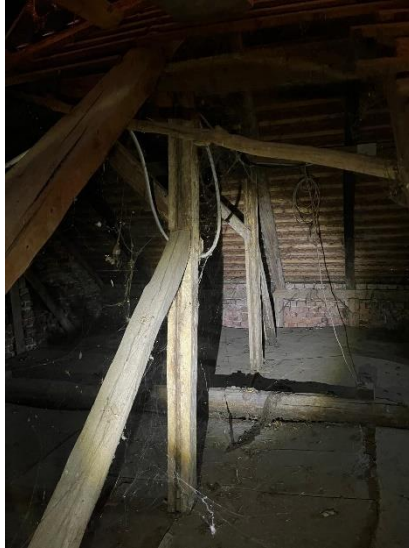
Slika 49.: Prikaz dvostruke stolice u prednjem dijelu kuće (Izvor: [29])
