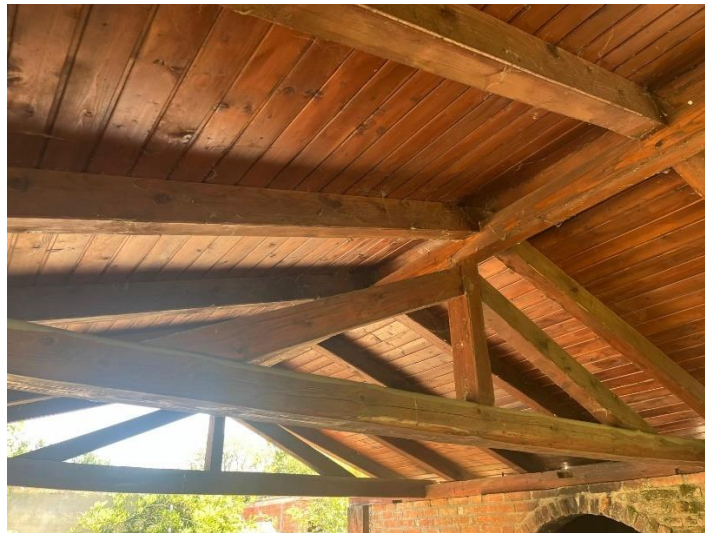
Slika 52.: Pogled na jednostruku visulju (Izvor: [29])
