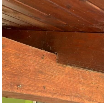
Slika 54.: Tesarski spoj zasjek (Izvor: [29])
