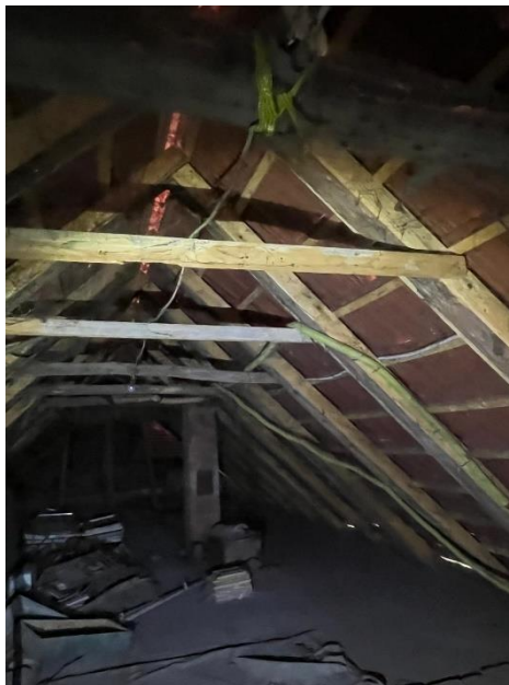
Slika 50.: Prikaz krovišta s pajantom u stražnjem dijelu kuće (Izvor: [29])
