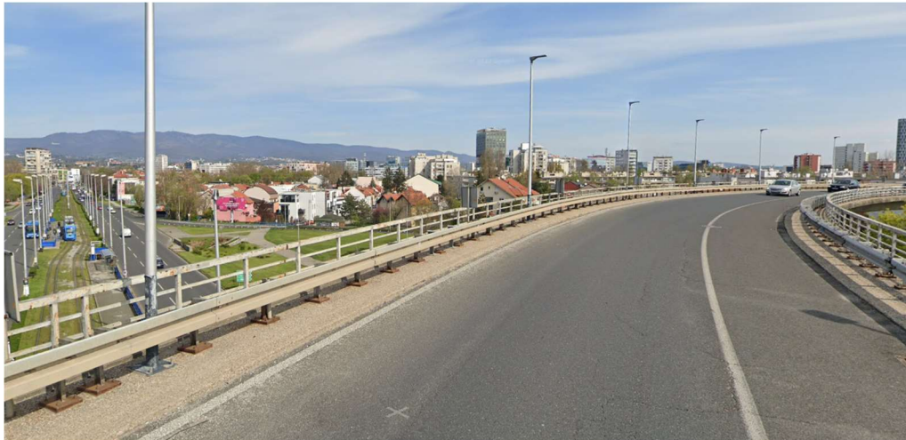
Slika 18.: Rasvjeta postavljena s vanjske strane zavoja na lokaciji Držićeva petlja (Izvor: [12])
