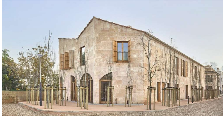
Slika 38: Zgrada sa socijalnim stanovima u Mallorci (Izvor: [47])
