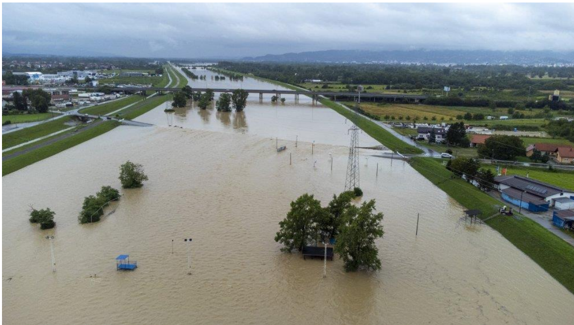
Slika 13. Oteretni kanal Sava-Odra koji štiti Zagreb i Veliku Goricu od velikih poplava [8]
