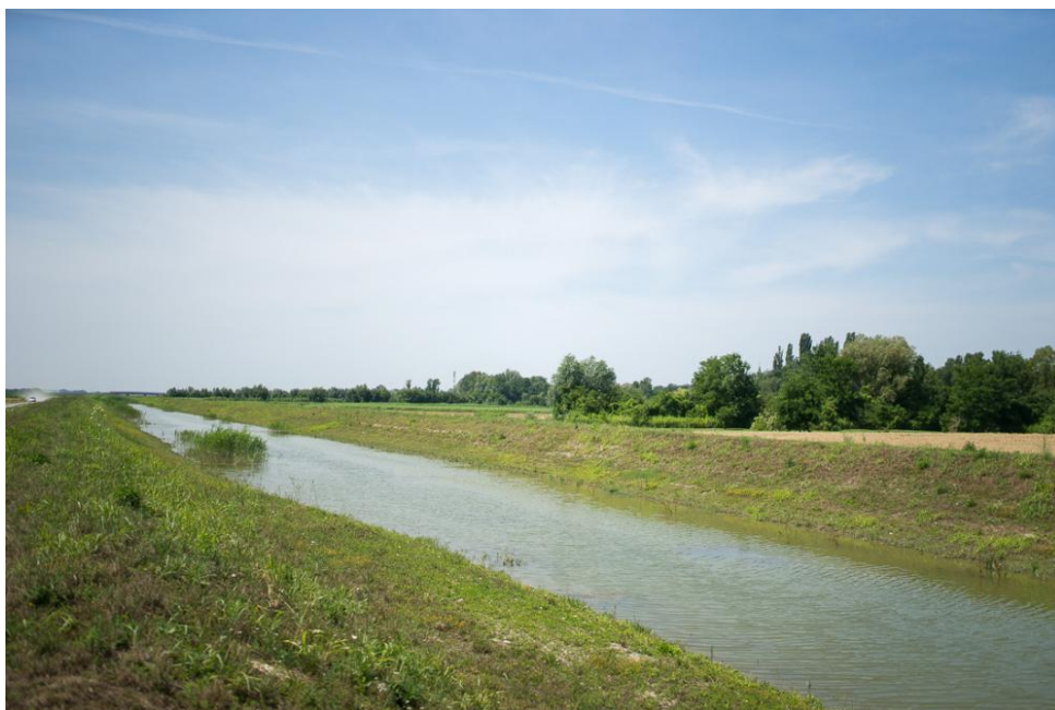
Slika 14. Kanal za navodnjavanje u Baranji, trenutačno najveći sustav za navodnjavanje u Hrvatskoj [9]
