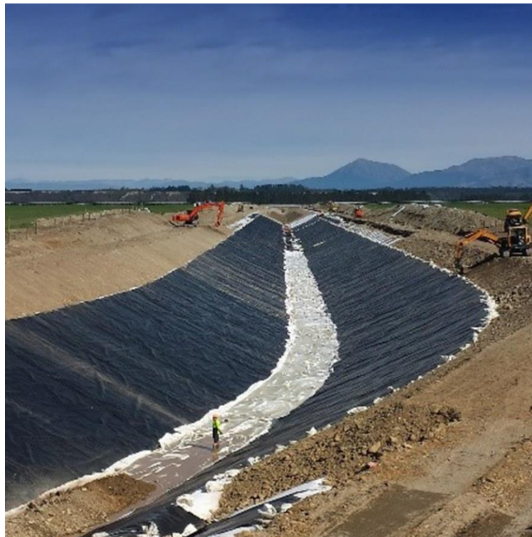
Slika 11. Obloga od plastične sintetičke folije [6]
