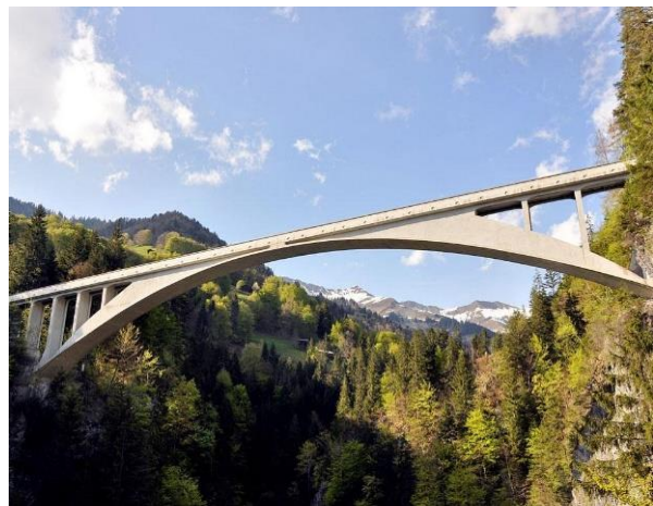
Slika 3.2. Salginatobel Bridge, Švicarska [8]
