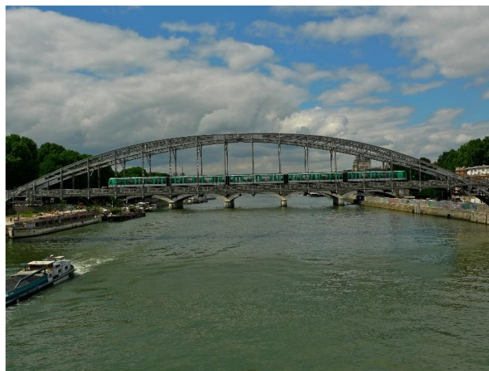
Slika 3.5. Viaduc d'Austerlitz, Pariz [11]
