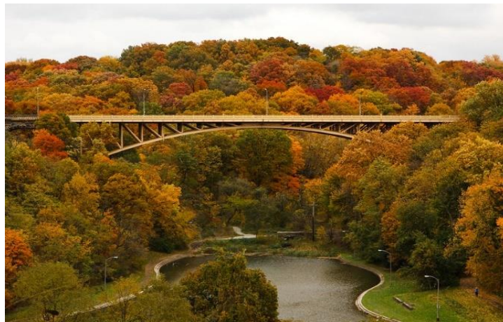
Slika 3.4. Panther Hollow Bridge, SAD (čelični trozglobni luk) [10]
