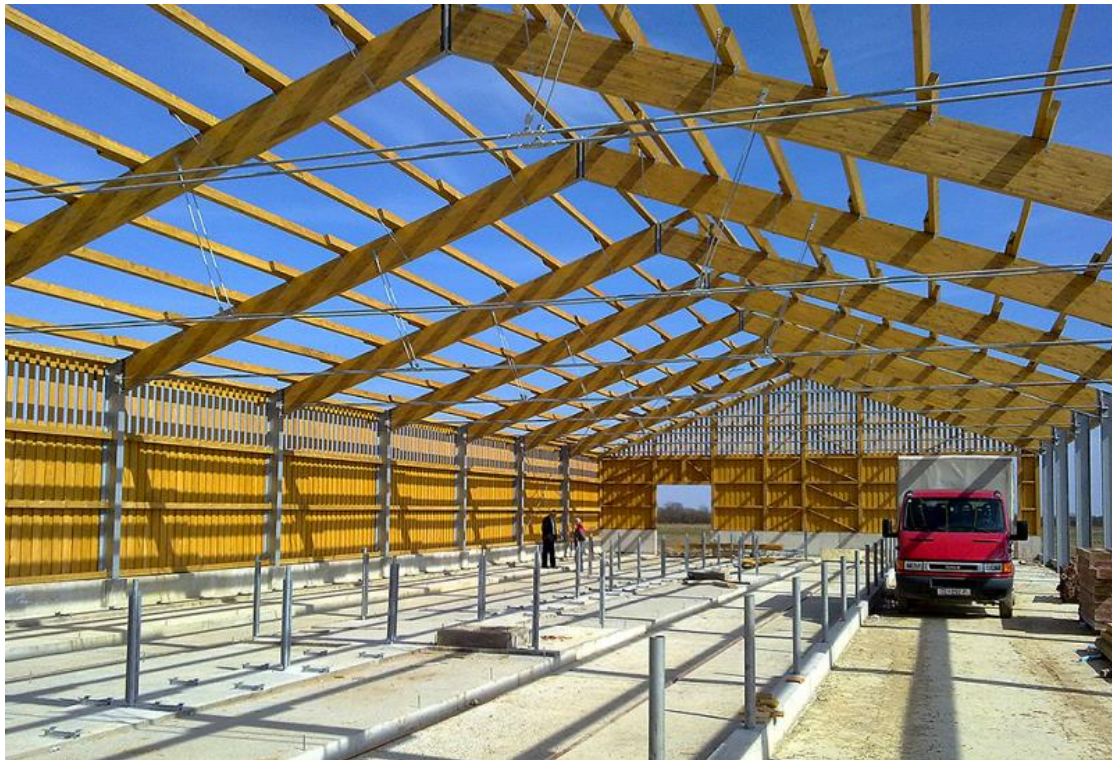
Slika 3.3. Krovna konstrukcija od LLD [9]
