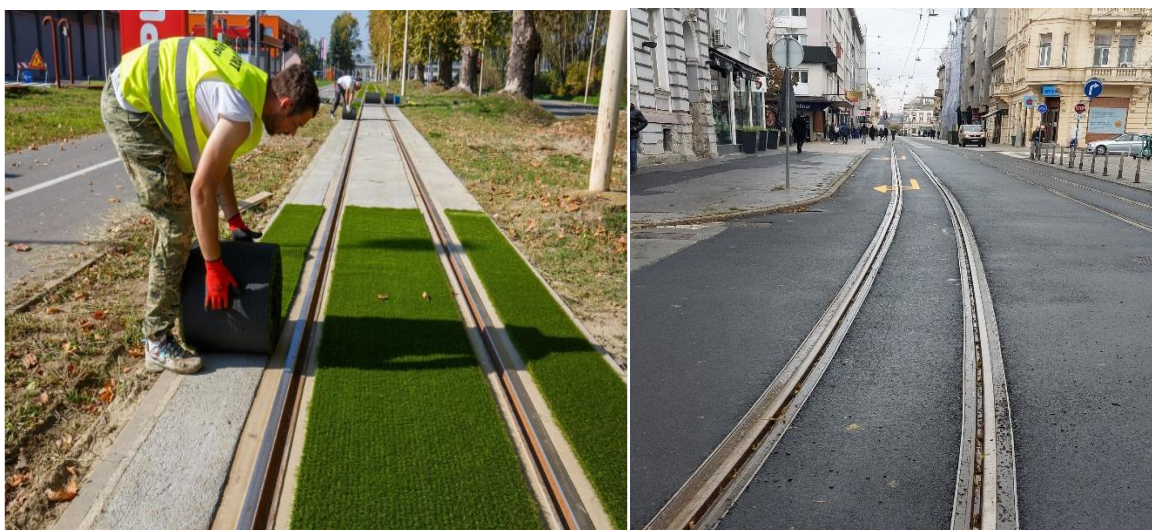
Slika 21.: Primjeri zatvaranja kolosijeka s umjetnom travom ili asfaltom u Osijeku
