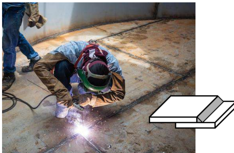
Slika 28: Preklopno zavarivanje ploča dna spremnika
