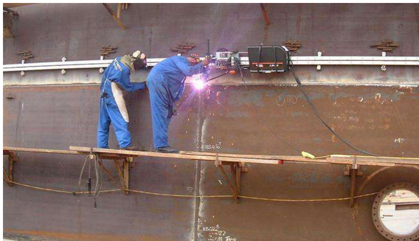
Slika 26: Zavarivanje dijelova spremnika
