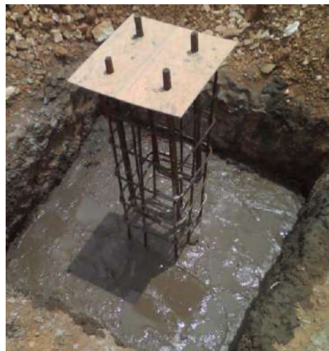
Slika 20: Temelj nosača povišenog spremnika
