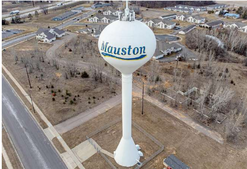
Slika 7: Povišeni spremnik na centralnom nosaču
