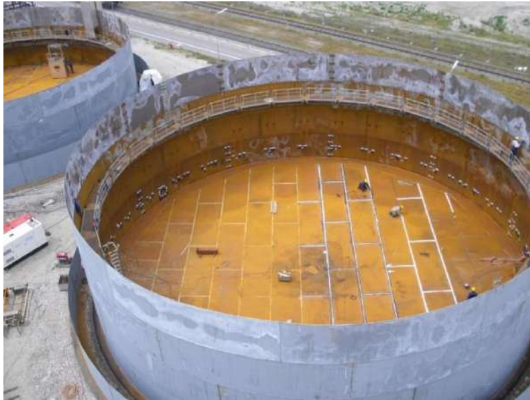
Slika 27: Raspored pravokutnih ploča dna spremnika
