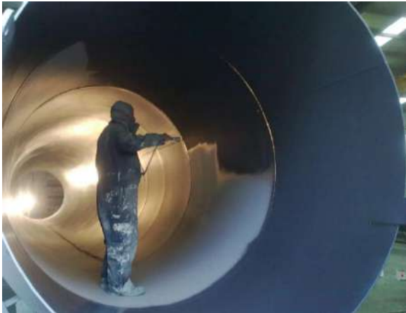
Slika 21: Zaštitni premaz unutarnje površine
