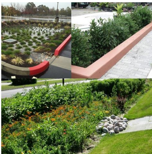
Slika 2.: Prikaz bioretencija, infiltracijskih kanala i žardinjera (Izvor: [6])
