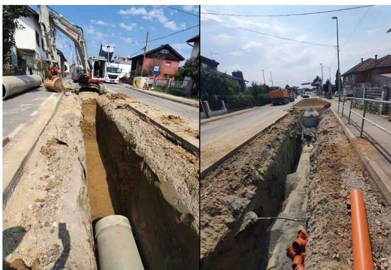
Slika 19.: Primjer izgradnje Aglomeracije Križevci (Izvor: Ivona Višak-Pavlović)
