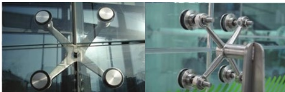
Slika 17.: Nosači na spider fasadi [8]
