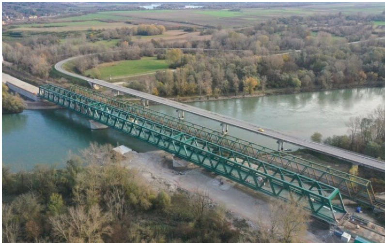
Slika 33. Željeznički most Drava na Botovu [14]
