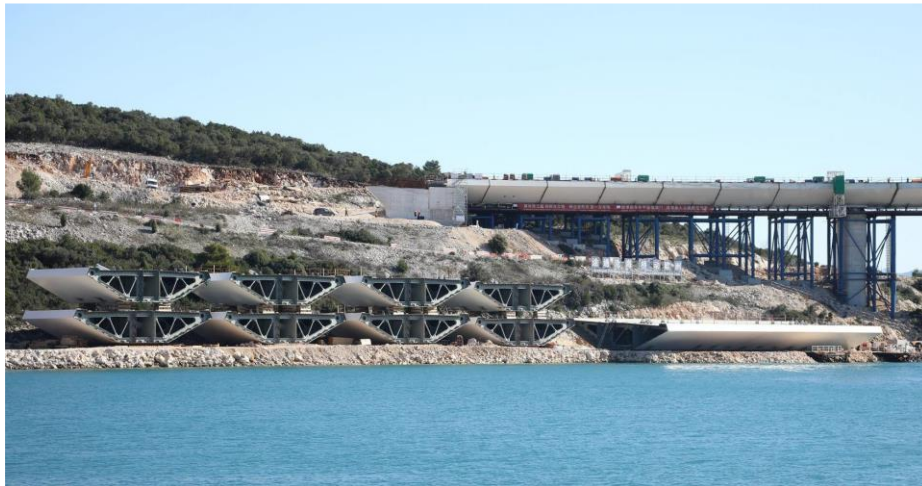
Slika 36.: Skladištenje čeličnih montažnih elemenata na obali
