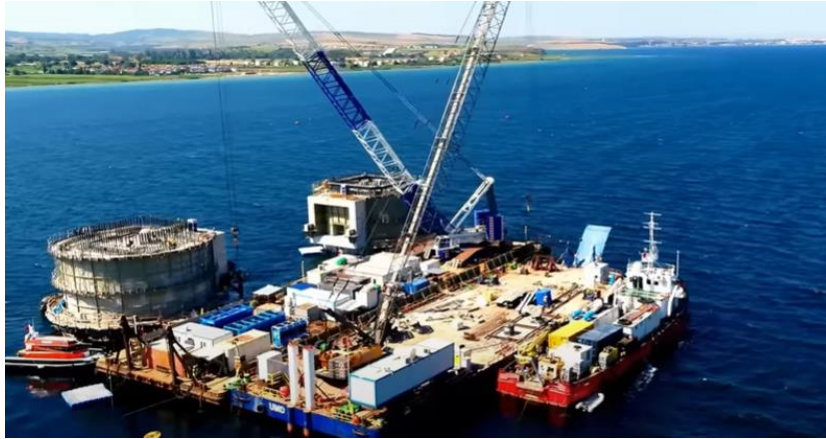
Slika 40.: Postavljanje kesona u more
