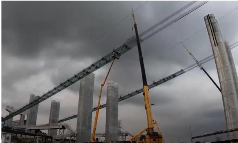
Slika 42.: Montaža specijalnih radnih mreža
