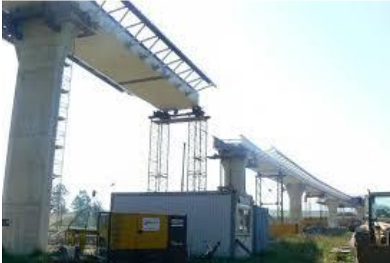
Slika 13.: Montiranje predgotovljenih elemenata rasponske konstrukcije mosta (Izvor: GRAĐENJE MOSTOVA , Arhitektonsko-građevinski fakultet, Sveučilište u Splitu)
