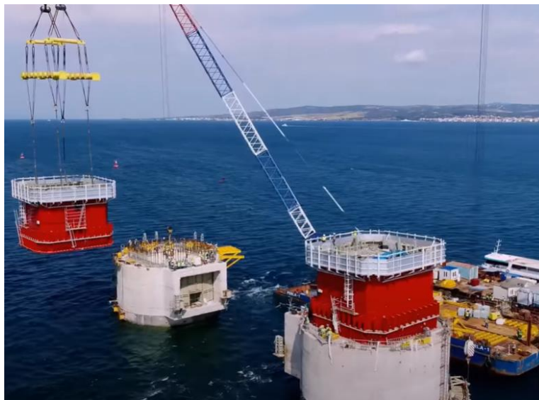
Slika 41.: Montaža prvih segmenata karakteristične crvene boje
