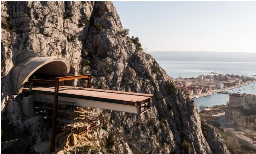
Slika 18.: Pogled iz zraka na kanjon rijeke Cetine
