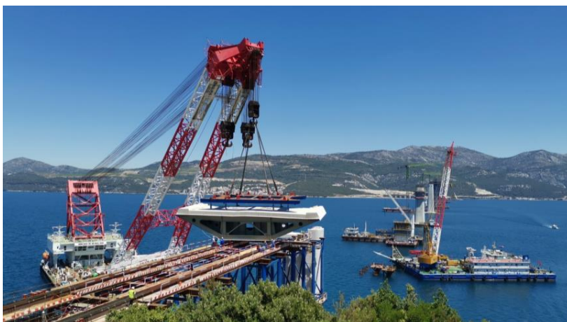
Slika 33.: Ugradnja segmenata sa plovnom dizalicom i skelom po kojoj se segmenti pomiču
