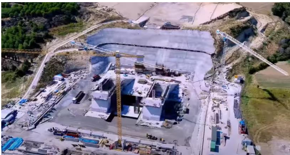
Slika 39.: Gradnja sidrenih blokova na obalama Europe i Azije
