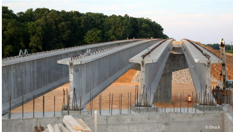
Slika 3.: Niz betonskih montažnih elemenata na mjestu ugradnje (Izvor: AEC magazine, A superior way to model precast girder bridges , 2022)
