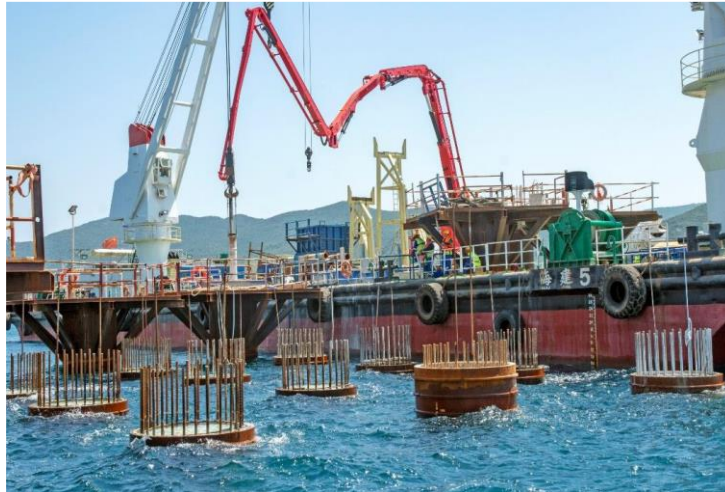
Slika 30.: Gradnja AB pilota pomoću broda na kojem je pumpa za beton
