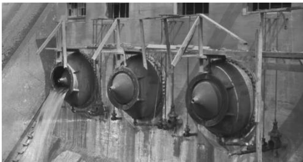
Slika 12.: Igličasti zatvarač na brani Bull Run [10]
